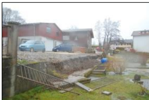
16.12.2011 Mur de soutènement affaissé entre les parcelles N°982 et N°583
