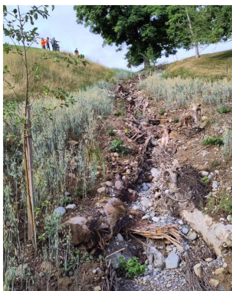
Figure 66: Protection longitudinale avec des troncs et fascines de saules.
