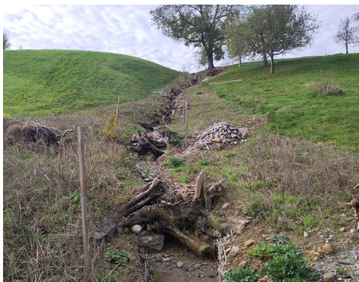
Figure 65: Souches utilisées comme seuil naturel.
