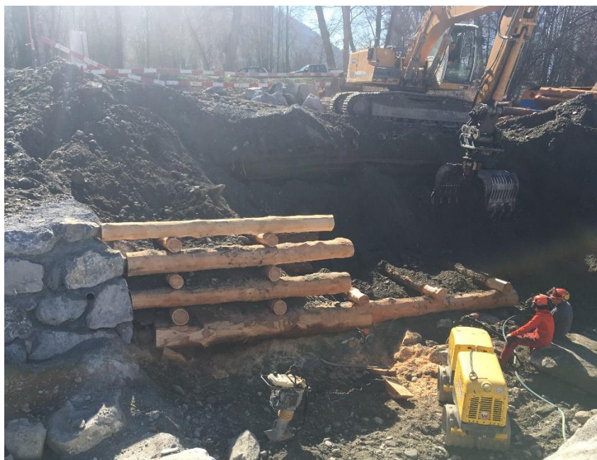
Figure 67: Exemple de construction de caisson végétalisé en bois.
